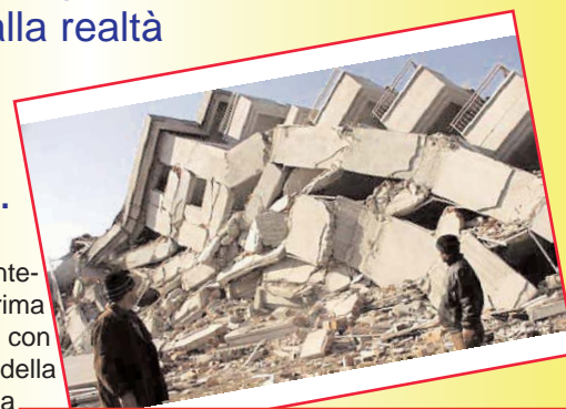
Un palazzo di sei piani distrutto dal terremoto
